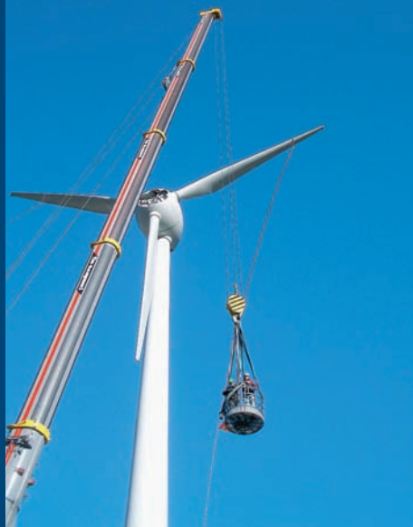
Aufbau der Windanlage Gütsch in Andermatt
