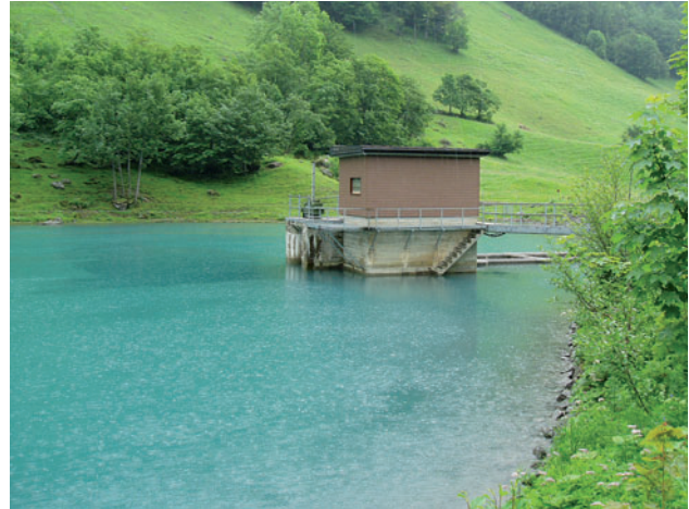
Wasserkraftwerk Bocki I und II, Elektrizitätswerk Erstfeld, naturemade star
